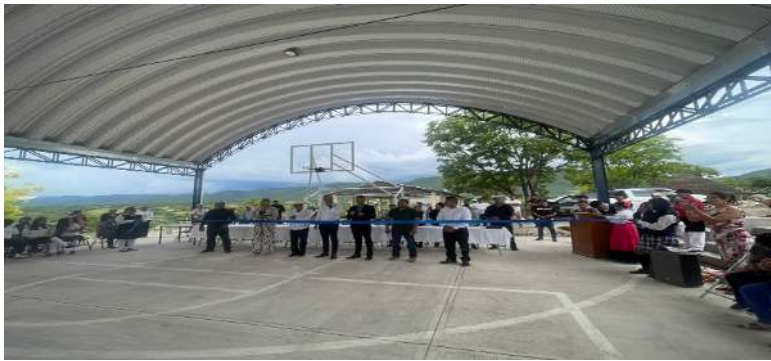
Entregamos la obra del Techado a la comunidad de San Miguel Atlapulco.
